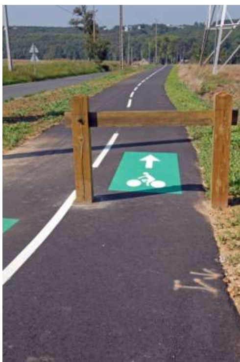
Liaison douce existante le long de la route de Pivot.
