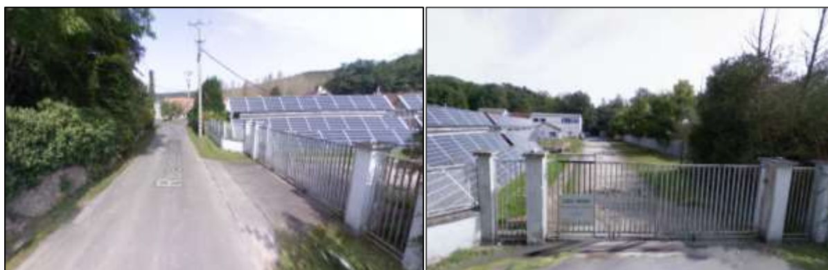
Cette intersection marquera l'entrée principale du site (vue depuis la rue de Chanteraine).
