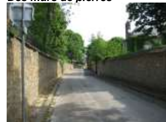
Des murs de pierres
